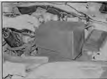
Рис. 4.20,а. Снятие изолятора с аккумулятора
