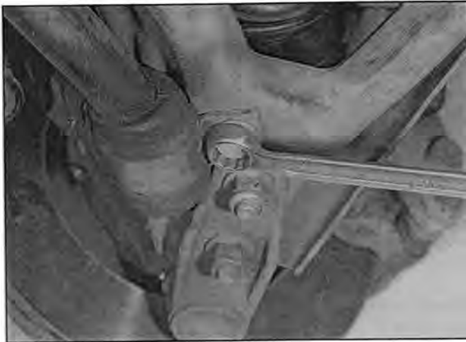
Рис. 6.4 Отверните болт крепления переднего стабилизатора поперечной устойчивости
