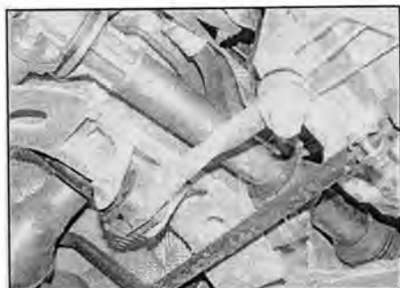
Рис. 8.24,а. Тяга заднее опоры силового агрегата
